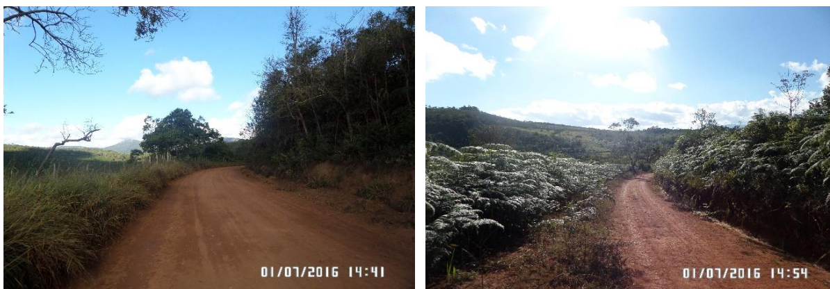
Figura 3.8 – Trechos de estradas vicinais em mau estado de conservação
