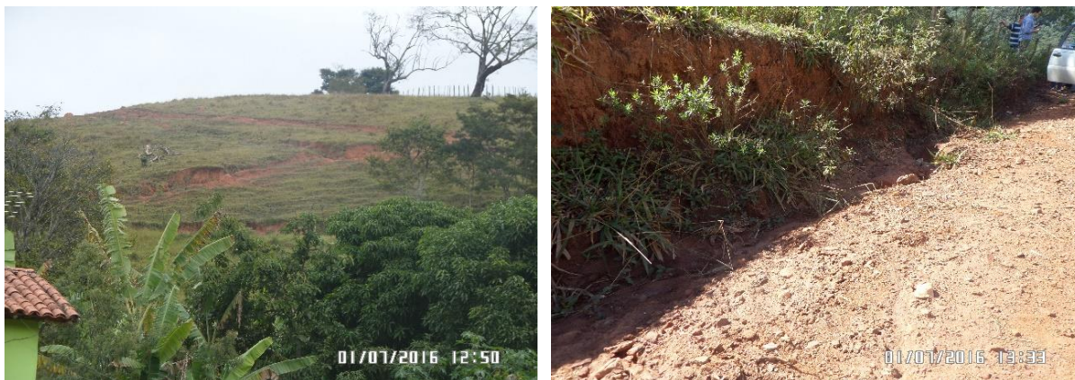
Figura 3.7 – Atividades erosivas e estrada vicinal mal conservada
